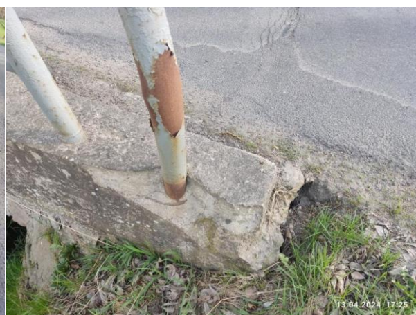
Poškozená levá římsa na začátku mostu
