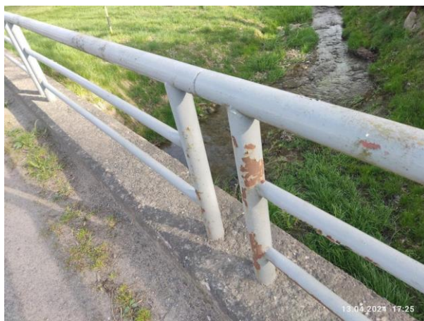
Stav nátěru pravého zábradlí
