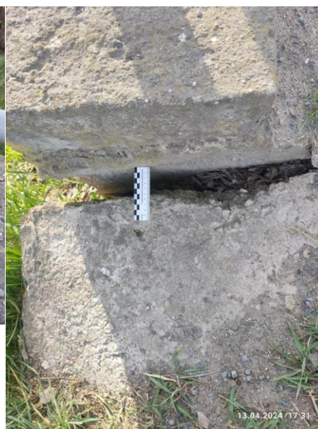
Utržená přibetonávka nakonci mostu vpravo
