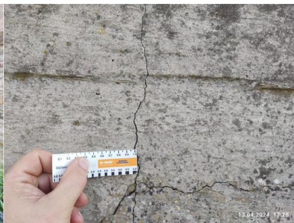
Trhlina cca 1 mm v levé čelní zdi
