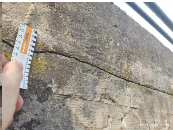
Trhlina cca 3 mm v pravé čelní zdi
