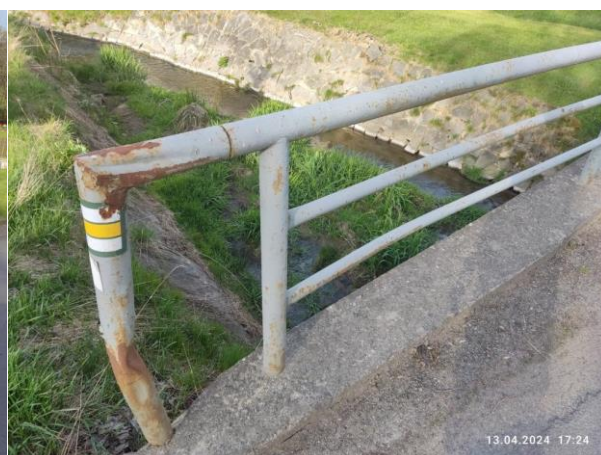
Stav nátěru levého zábradlí
